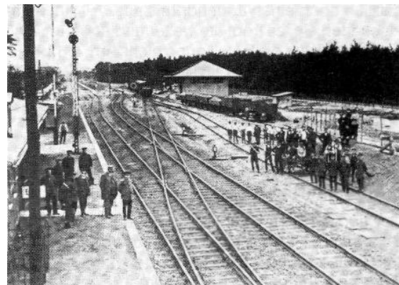
Bild 4: Im Jahre 1914 wird der zweigleisige Ausbau der Strecke und der Bau des Bahnhofsgebäudes „Forsthaus“ vollendet.
