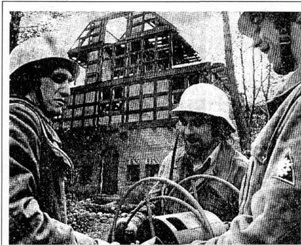
(Abb. 5) Alle Hände voll zu tun hatten die Leute vom Katastrophenschutz, um den Praasshof in die Knie zu zwingen. Trotz eines Großaufgebotes an Helfern hielt der alte Fachwerkbau stand.
