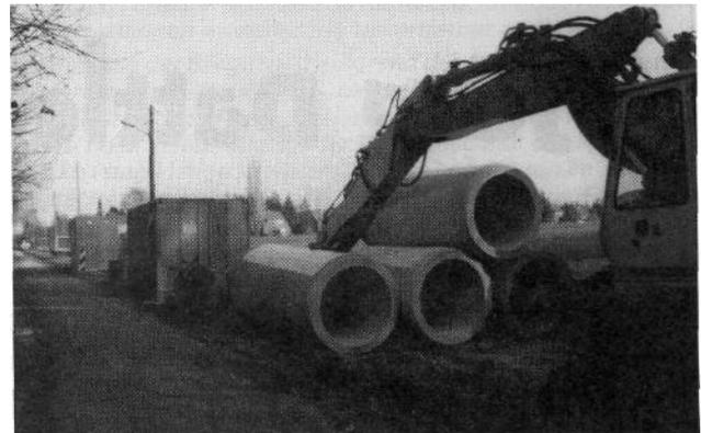
Preßgrubenwand, Rohrverlegekran und Betonrohrglieder an der Waldecke
