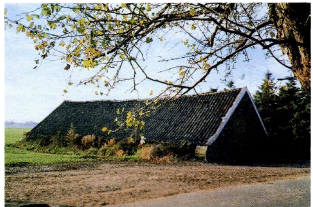
(Abb. 9) Eine alte Rübenscheune liegt gegenüber dem Sterkenhof. Leider zerstörte ein Sturm 1990 das mit alten Ziegelbrandpfannen gedeckte Dach, das heute mit großen Platten belegt ist.
