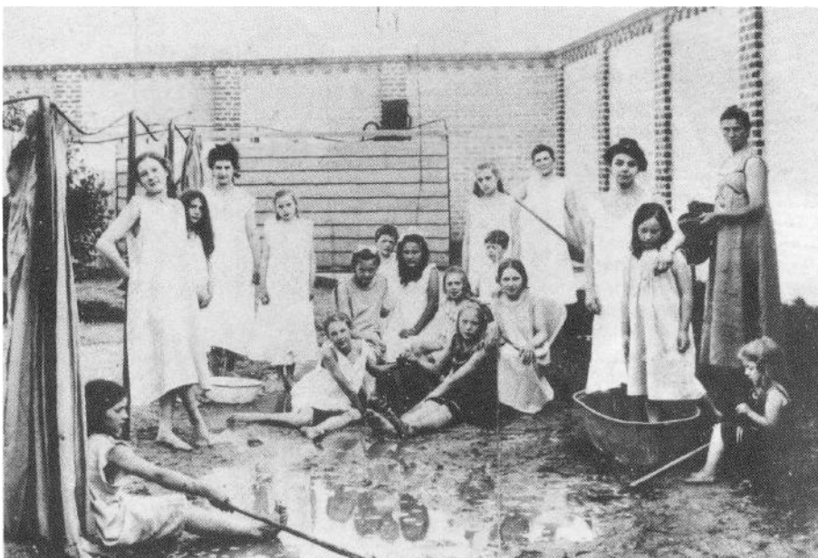
Abb.12. Blick in die Südostecke des „Damen-Bade-Parks“ mit Pumpe (hinter dem Bretterverschlag) und „Schlammbad“. Zur besseren Orientierung: Diese Stelle befindet sich etwa dort, wo heute das Haus Nr. 27 am Meisenweg steht.
