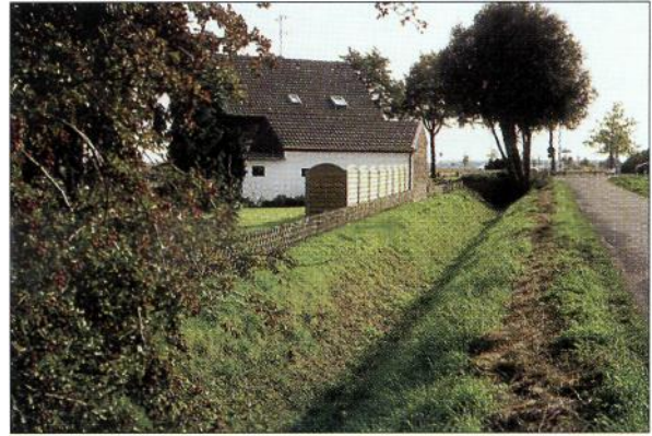
Dorfflöt als Vorfluter und Unterführung in Vorst
