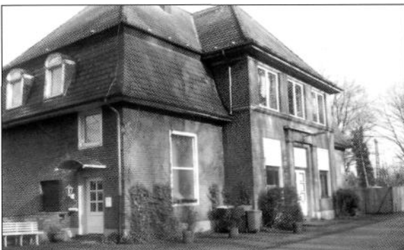
Das alte Bahnhofsgebäude
