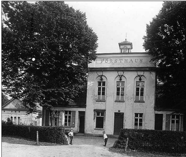
Aus Heft 31/2002 Seite 71: Forsthaus nach dem Umbau 1930/31
