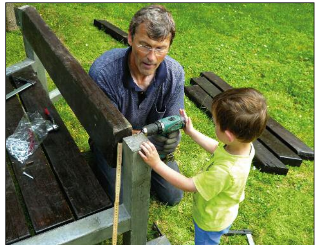
Willi Dülks und Jannis montieren die fertigen Bänke neu
