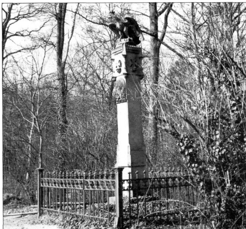
Das beschädigte Denkmal an der Hückelsmay wird wieder hergerichtet.
