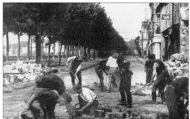
OT – Bei der Beseitigung von Bombenschäden
