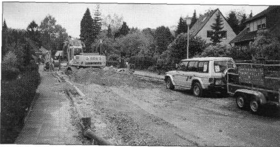
6. Mai 2002 – Baustelle Hochbendweg in Blickrichtung zum Bellenweg Foto: R. Niemczyk
