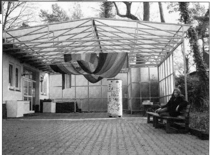
Das neue Vordach am Jugendheim der Johanneskirche
