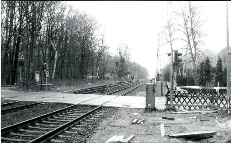
Hier entsteht der neue Bahnhof
